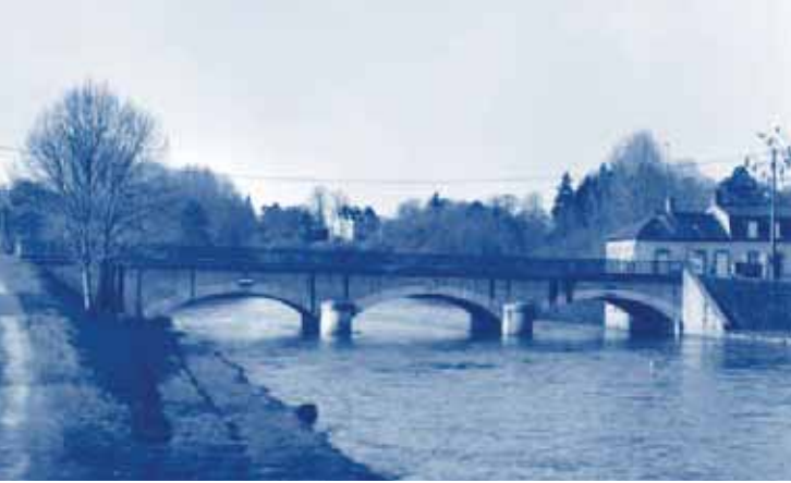
Le pont de Montgiroux.
